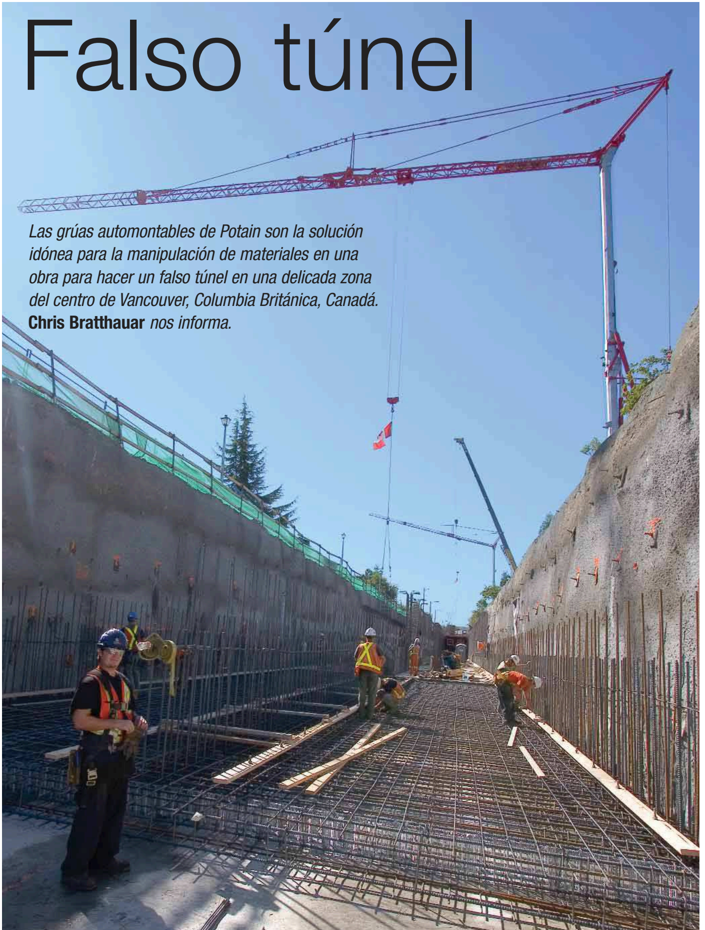
Las zanjas del nuevo proyecto ferroviario oscilan entre los 6 m y los 14 m (20 y 46 ft) de profundidad.
